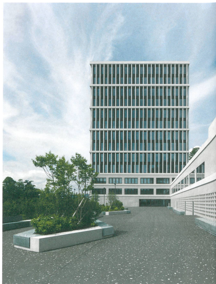
Aufstrebende Eleganz: Die aussenliegende Tragstruktur aus sehnigen Betonfertigteilen bindet die fünf doppelgeschossigen Gerichtsabteilungen optisch zusammen.
