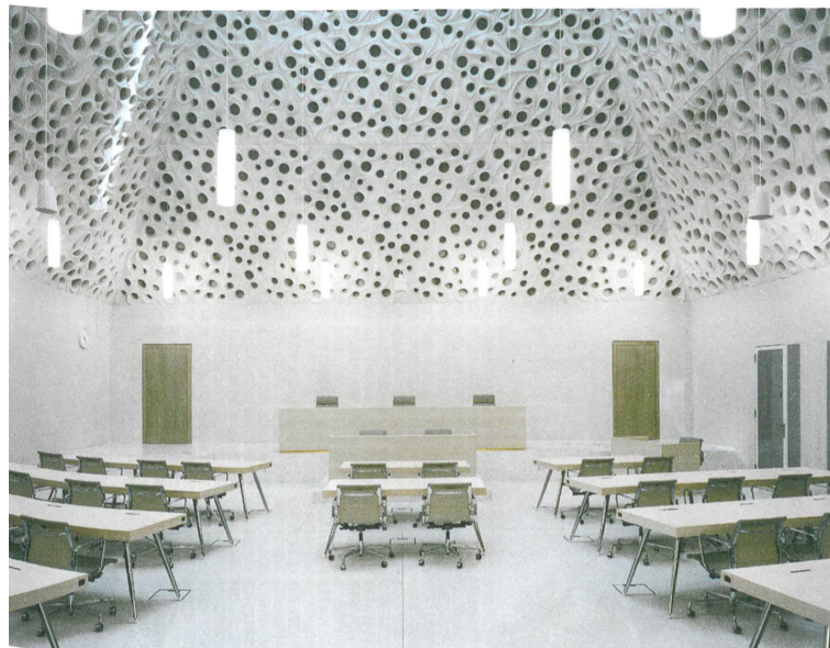
Abstrahierte Gerichtslinde aus Betonfertigteilen: Unter der Kuppel sitzen Anklage und Verteidigung in Bellinzona den Richtern gegenüber.
