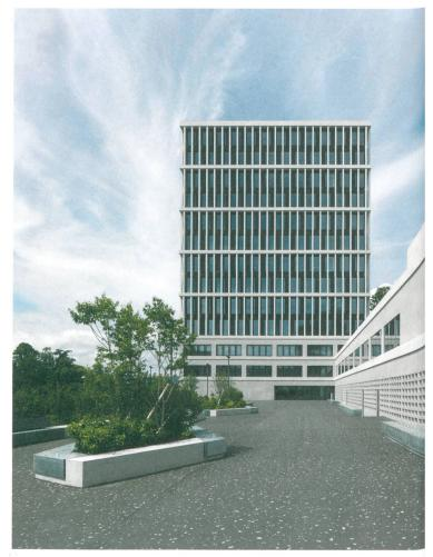
Aufstrebende Eleganz: Die aussenliegende Tragstruktur aus sehnigen Betonfertigteilen bindet die fünf doppelgeschossigen Gerichtsabteilungen optisch zusammen.
