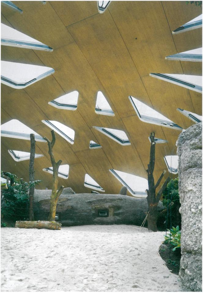
Künstliche Natur: Gucklöcher in einem begehbaren Baum aus Beton geben den Blick auf die Elefanten frei. Darüber die unregelmässig mit Luftkissen durchlöcherte Dachschale.
