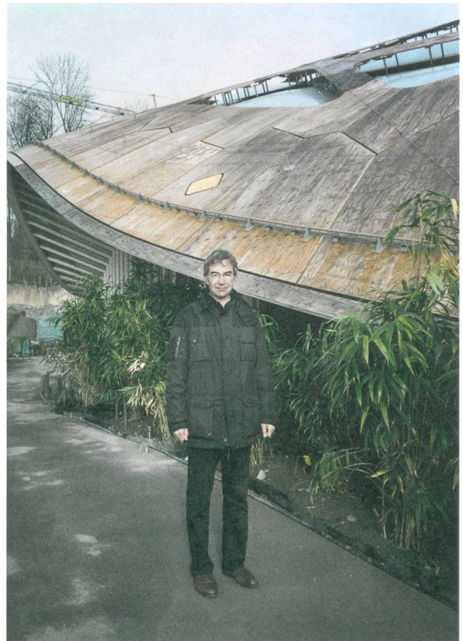
Der Bauingenieur Carlo Galmarini und die Pièce de Résistance: Der Ringbalken der Dachschaale ist auf 200 Tonnen Zug vorgespannt.
