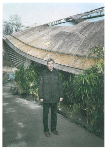
Der Bauingenieur Carlo Galmarini und die Pièce de Résistance: Der Ringbalken der Dachschale ist auf 200 Tonnen Zug vorgespannt.
