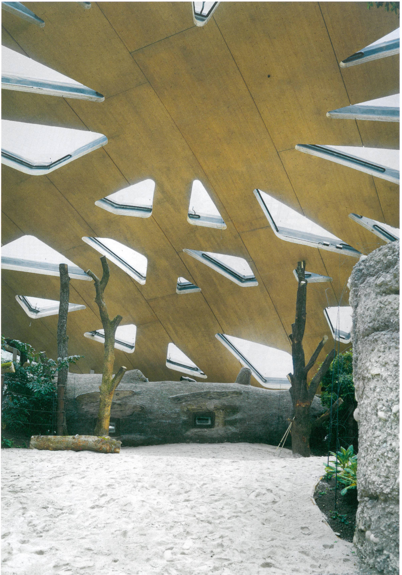
Künstliche Natur: Gucklöcher in einem begehbaren Baum aus Beton geben den Blick auf die Elefanten frei. Darüber die unregelmässig mit Luftkissen durchlöchernte Dachschaale.
