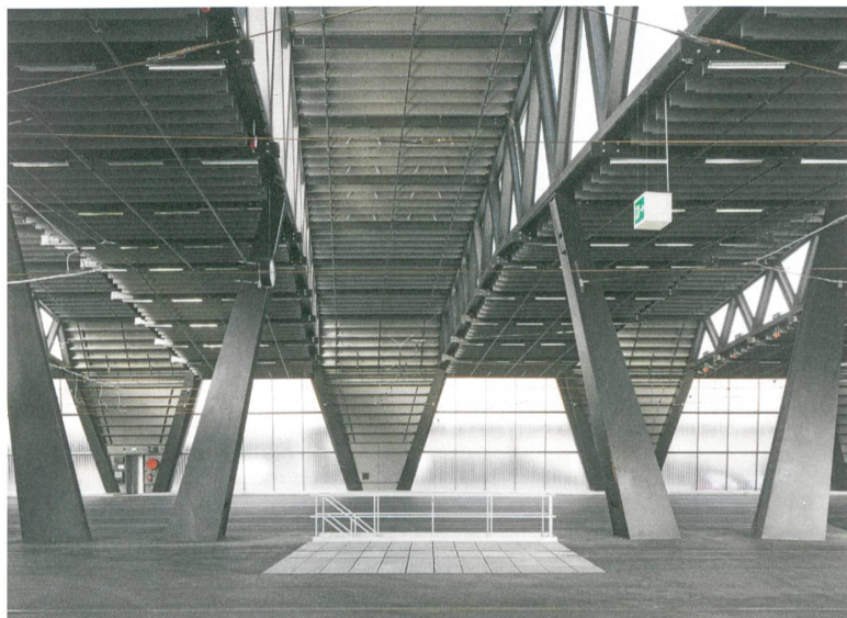
Verglaste Seitenwände und Stahlfachwerkträger an der Decke lassen so viel Sonnenenergie ins Haus, dass im Winter nicht geheizt werden muss.
