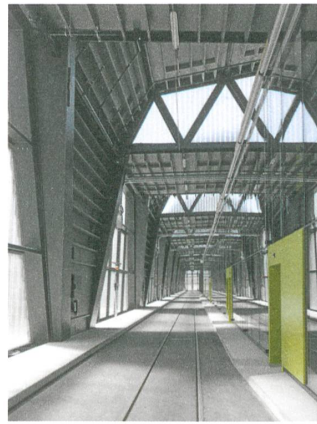
Plastische Wirkung eines statischen Kraftakts auf mehr als 200 Metern Länge.
