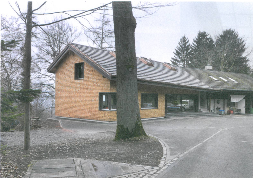
Der Werkhof am Fusse des Uetlibergs mit Büro für den Förster und Garderobe für die zwei dutzend Forstleute.
