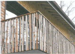
Eibenhholz schmückt als Schindel die Fassade und als Geländer den Balkon.
