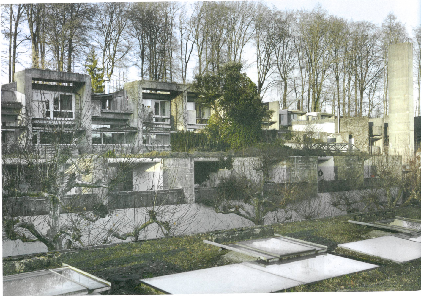
Blick von den Dächern über den Dorfplatz mit seinen alten Platanen: Müssen sie für den Kran gefällt werden?
