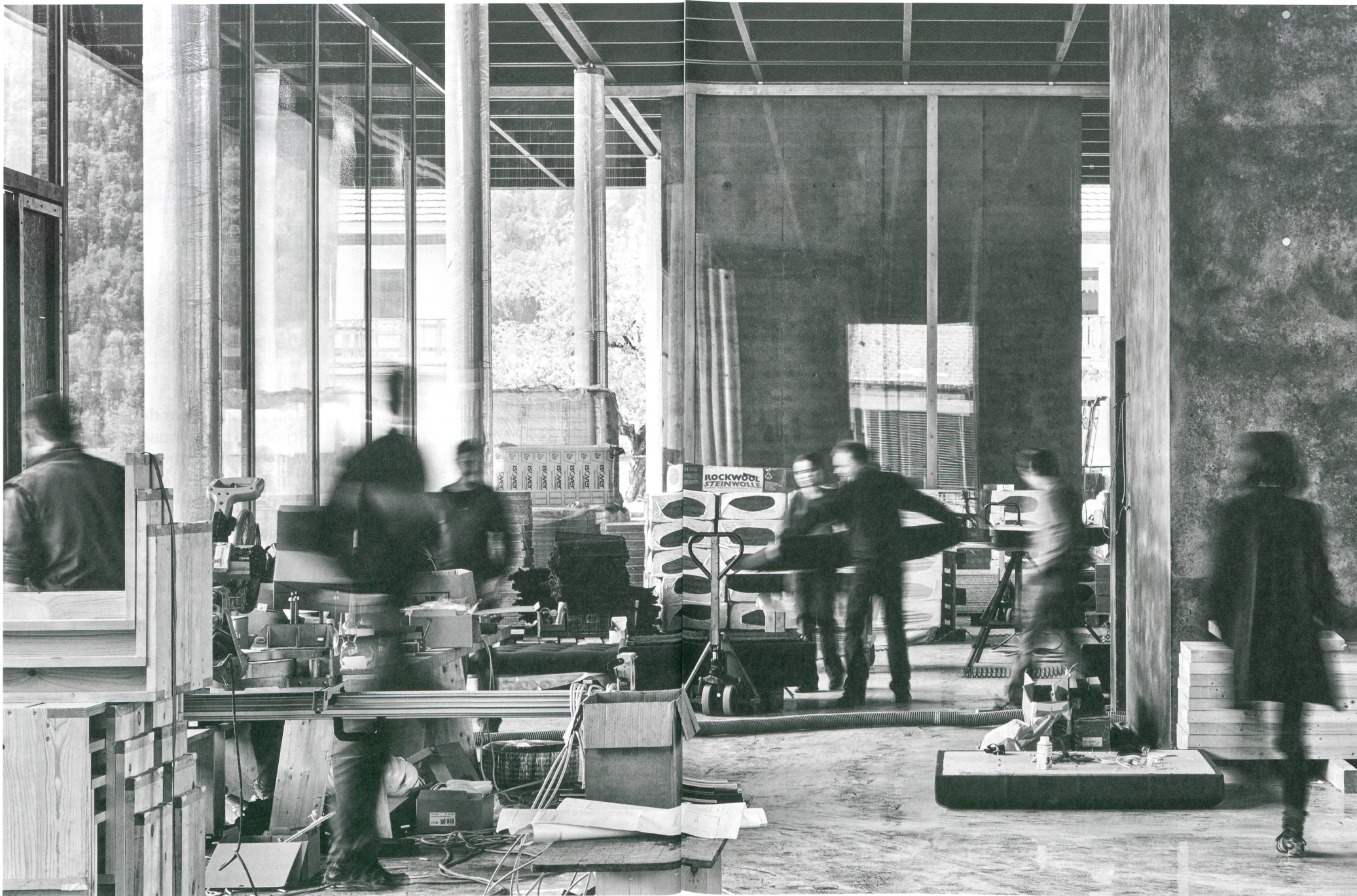
Die mehr als 500 Polsterkissen, die unter der Kassettendecke hängen, wurden direkt auf der Baustelle hergestellt. Foto: Adolf Bereuter
