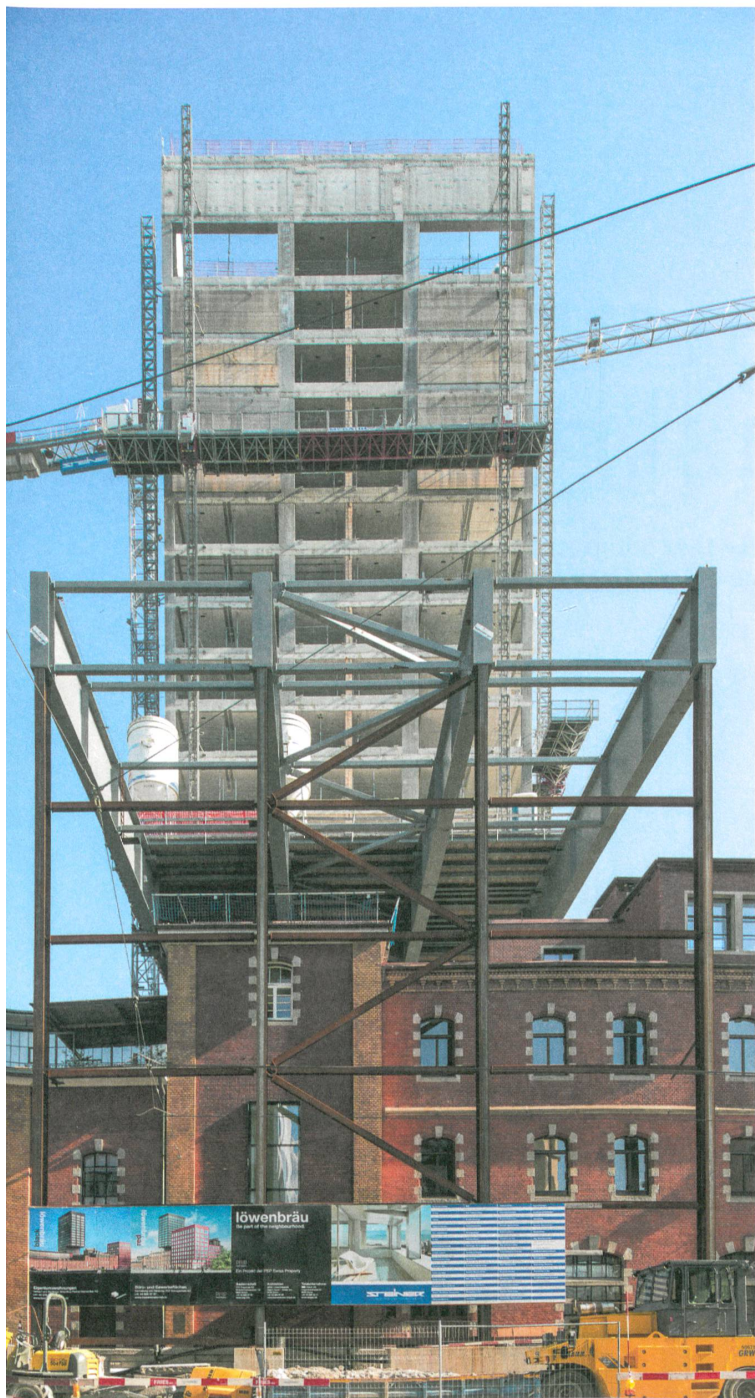
Während der Bauphase fing ein Stahlgerüst die Auskragung über dem Altbau ab. Foto: Thomas Zwyssig
