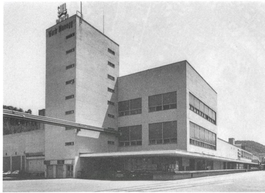
Der Wasserturm und der «Holländerbau» sollen erhalten bleiben.
