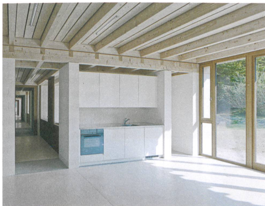
Alles ist direkt gefügt: Kalksandsteinmauern und Holzdecke.
