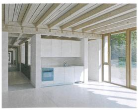
Alles ist direkt gefügt: Kalksandsteinmauern und Holzdecke.
