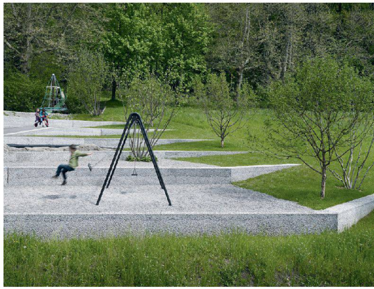
Mauern aus Sickerbeton terrassieren das Schulgelände Göttibach in Thun.
