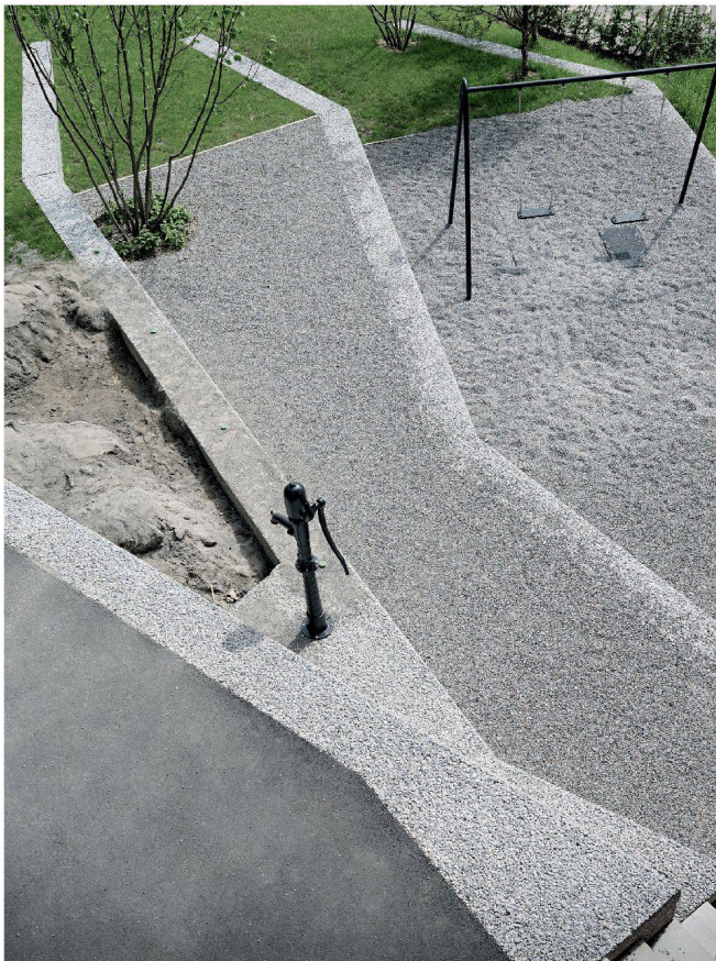
Mauern aus Sickerbeton terrassieren das Schulgelände Göttibach in Thun.
