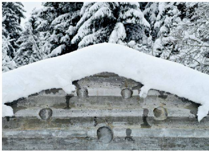
Als Abguss eines ruinösen Strickbaus hält der Neubau die Erinnerung an das Alte wach.
