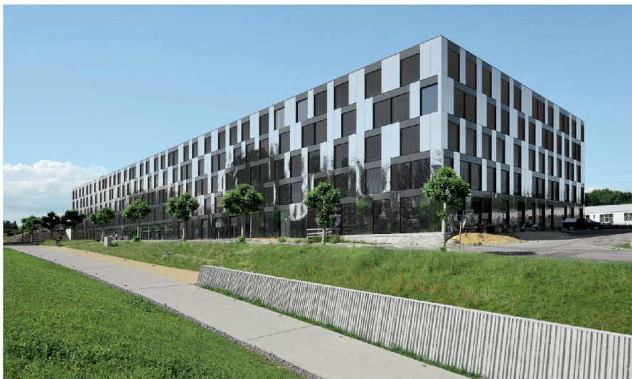
Abwechselnde Stahlpaneele und Glasflächen geben jedem Geschoss seinen eigenen Rhythmus. Foto: Pierre Boss
