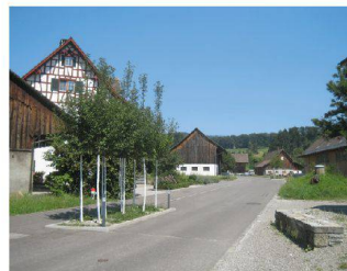
Strassenumgestaltung Weiler Burg, Meilen ZH Raderschallpartner
