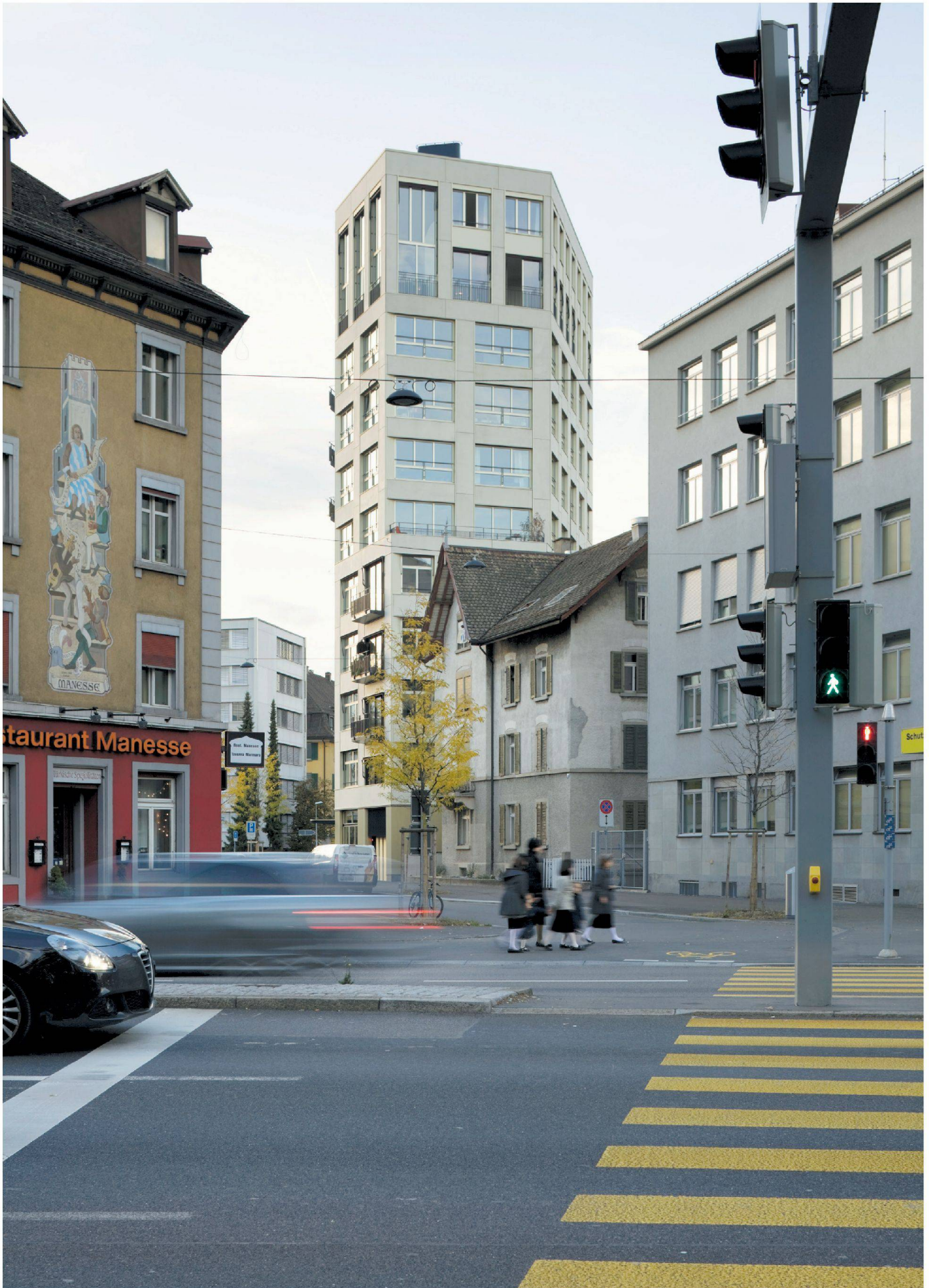
Mit seiner unregelmässigen Grundform und der Gliederung seiner Höhe fügt sich das Haus in die vorhandene Stadt ein.
