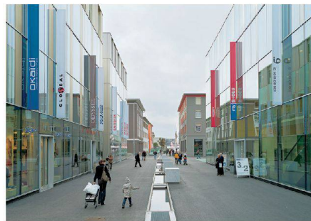
64 Überbauung Les Mercier
