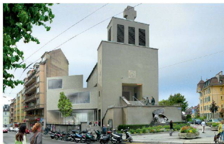
28 Temple de St-Luc – Maison de quartier de la Pontaise
