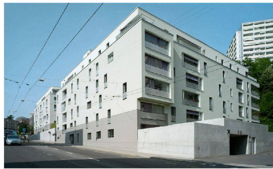
16 Wohnhäuser La Borde
