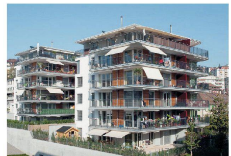
20 Wohnüberbauung Les Valenciennes
