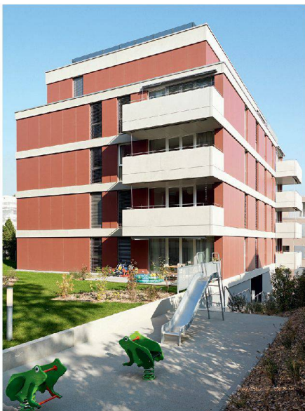
25 Wohnhäuser Hauts de Beaumont
