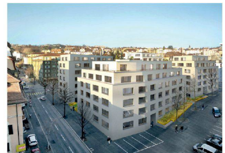
8 Wohnhäuser Avenue de Morges
