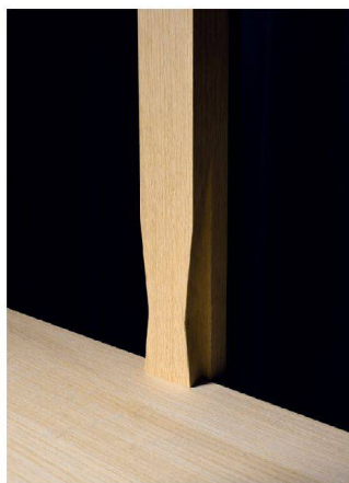
Wie ein Schwalbenschwanz gefügt.
