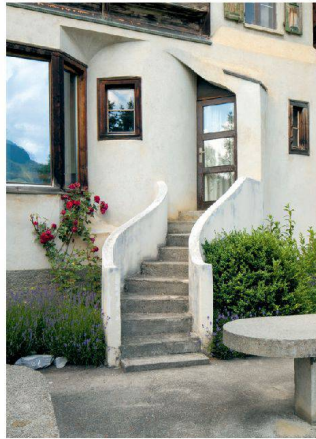
Ustria Caffè de Mont, Vella: neue Fassade zum Garten mit s-förmiger Treppe.
