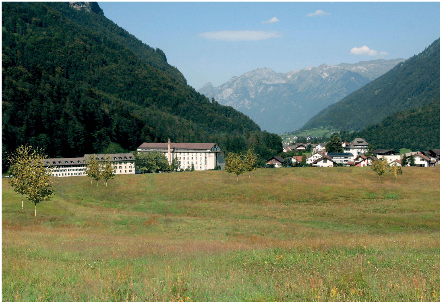
Der Zukunftsentwurf für das Grosstal: Ausgeräumte Landwirtschaftsflächen und die bewaldete Westflanke rahmen die auf ihre zukünftige Nutzung wartenden Industriebauten ein.
