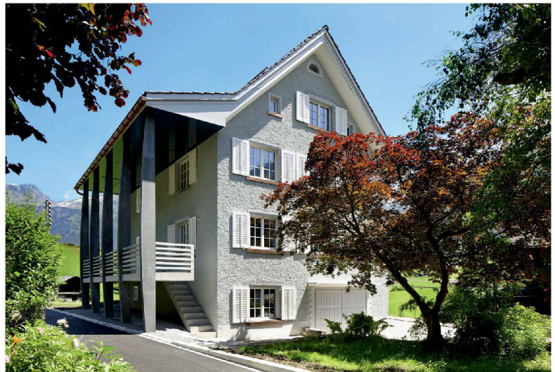
Das Bürgerhaus in Nidfurn erhielt auf der Gartenseite eine Terrasse, grosszügig und kräftig gestaltet. Foto: Ralph Feiner
