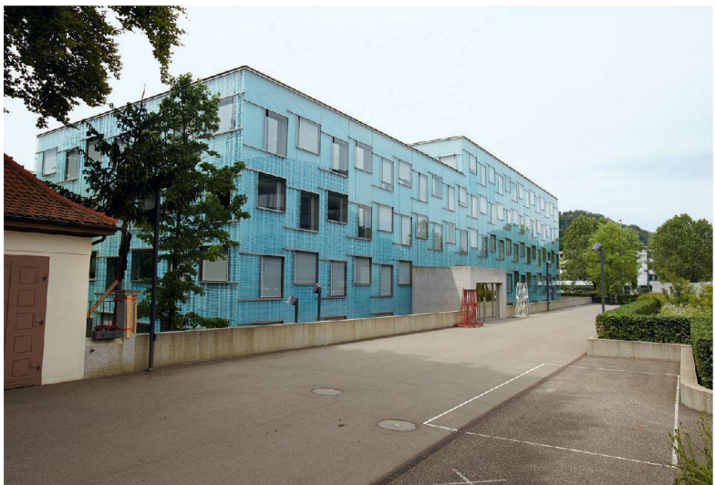
Bürogebäude NOK, Baden, 2007. Architektur: Rolf Meier / Martin Leder.
