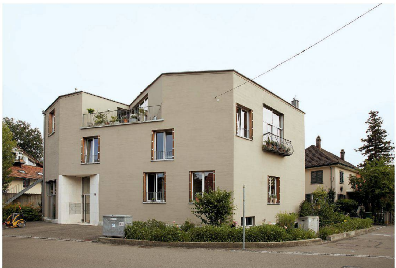
Wohnhaus Wiesenstrasse, Winterthur, 2004. Architektur: Knapkiewicz & Fickert.
