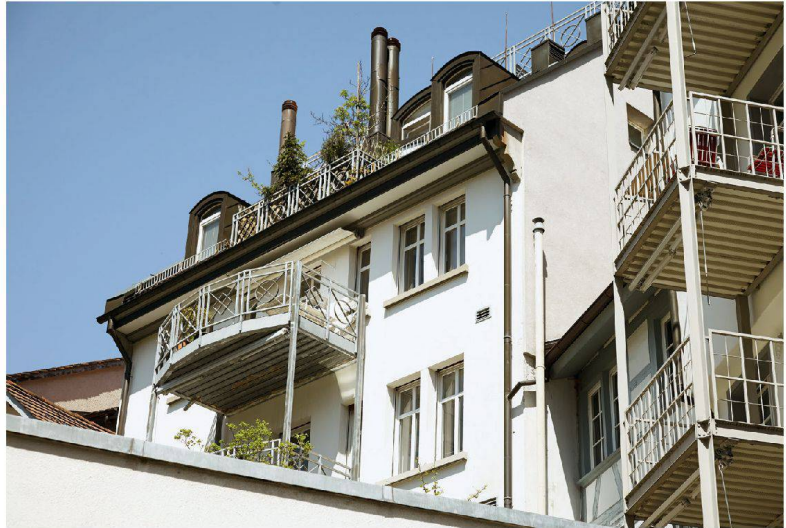
Sanierung Spisergasse, St. Gallen, 1988. Architektur: Senn.
