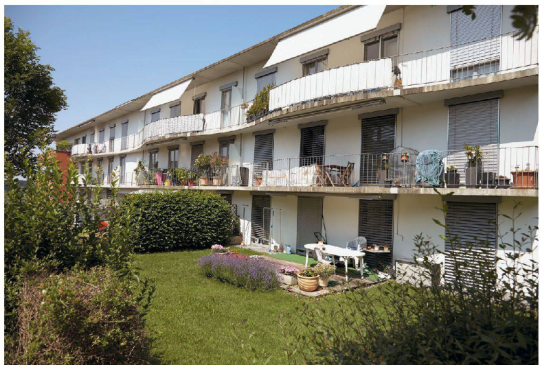
Wohnüberbauung Achslengut, St. Gallen, 1997. Architektur: Senn / Baumschlager Eberle.
