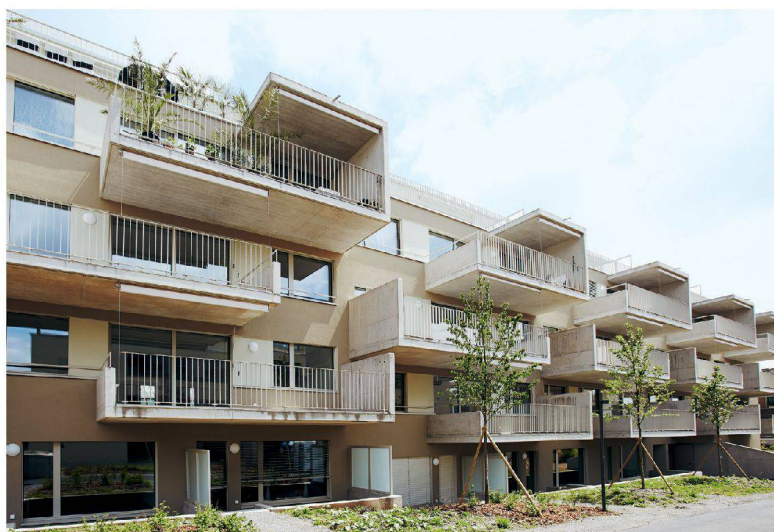
Wohnüberbauung Obstgarten, Hedingen, 2013. Architektur: Leutwyler Partner.
