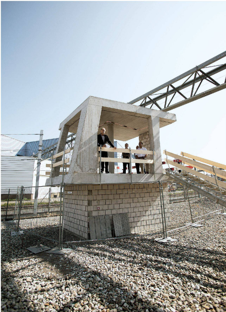
Ein «Mock-up», gleich neben der Baustelle, als Entscheidungs- und Kommunikationshilfe: So wollen wir den Beton!
