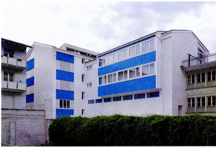
Hofseitige Ansicht mit dem Atelierhaus im Rücken des Strassenbaus.
