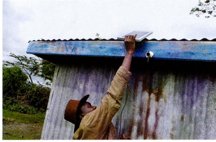
Das Solarpaneel auf dem Dach ist ein Standardprodukt.
