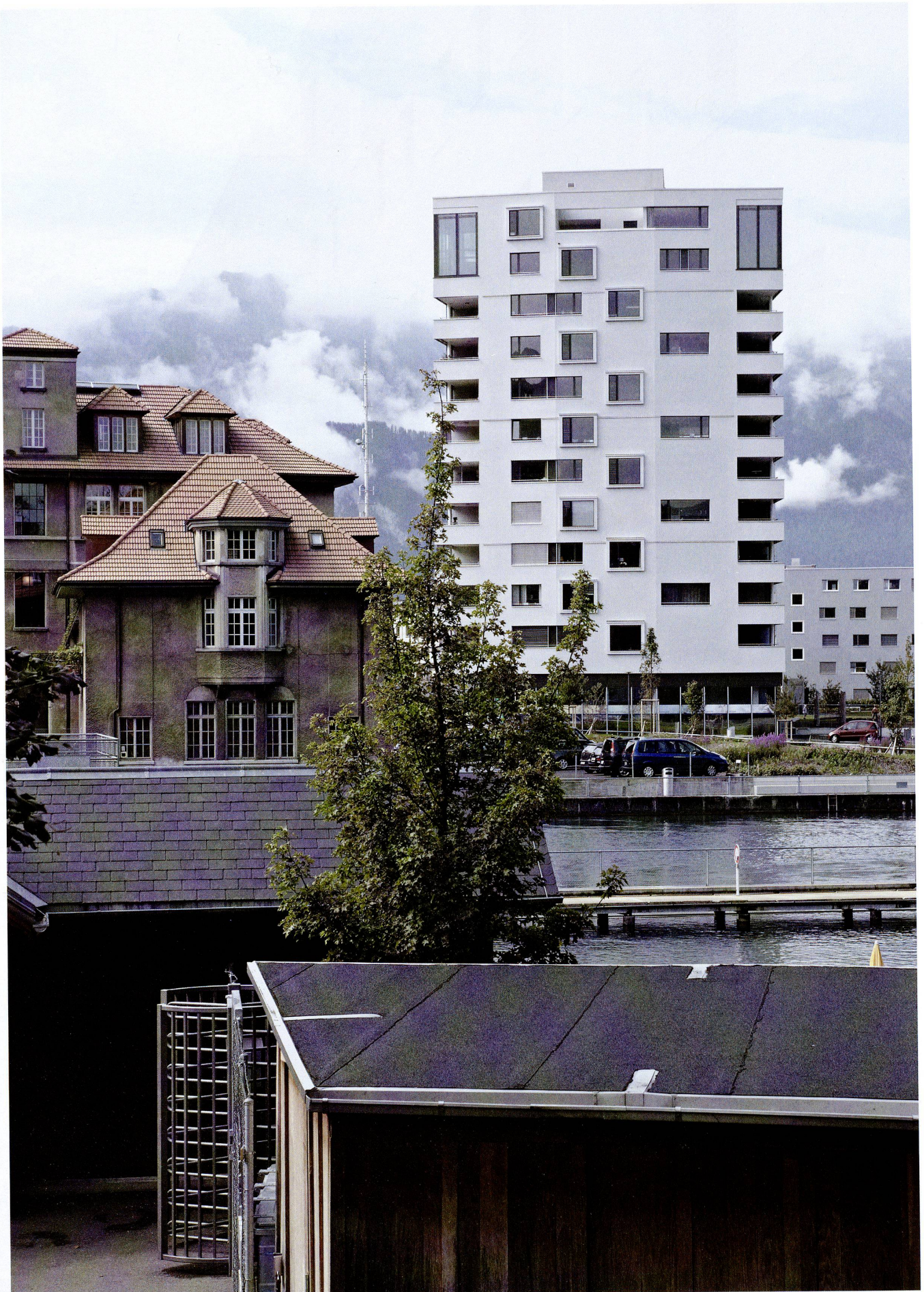
Ein Hochhaus macht den Auftakt zur Siedlung auf dem Selve-Areal in Thun. Blick vom Flussbad Schwäbis, links die letzten Altbauten.
