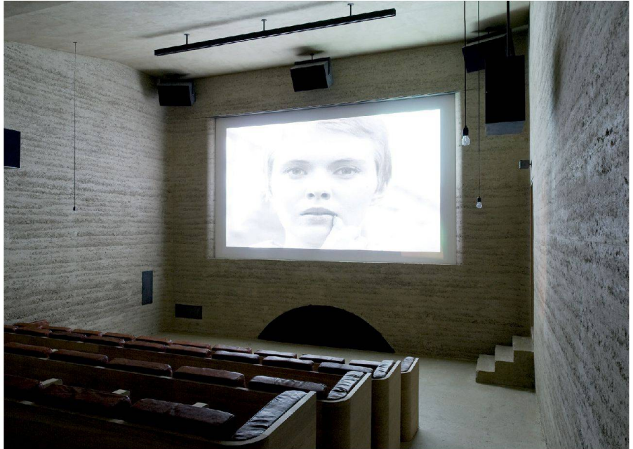
Stampflehmwände umfassen den Kinosaal in Ilanz. | Rammed earth walls surround the cinema in Ilanz.
