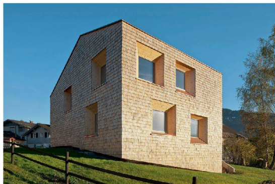
Die Aussenwand ist mehr als achtzig Zentimeter dick. | The exterior wall is more than 80 cm thick.
