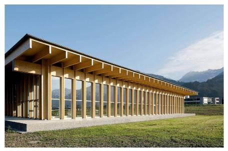
Dritter Pavillon des Maschinenbauers Trumpf in Grüsch: ein lichter Holzbau auf einem Betonsockel. Foto: Ralph Feiner
