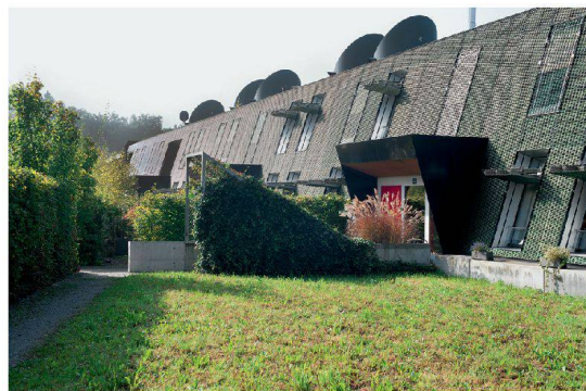
Das eher abweisende Äussere lässt nicht auf die räumliche Vielfalt im Innern der Adliswiler «Wohnunikate» schliessen. Foto: Katharina Lütcher
