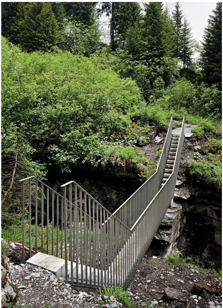
Die «Brücke am Pilzfelsen» führt nicht nur über die Schlucht, sondern in sie hinein.
