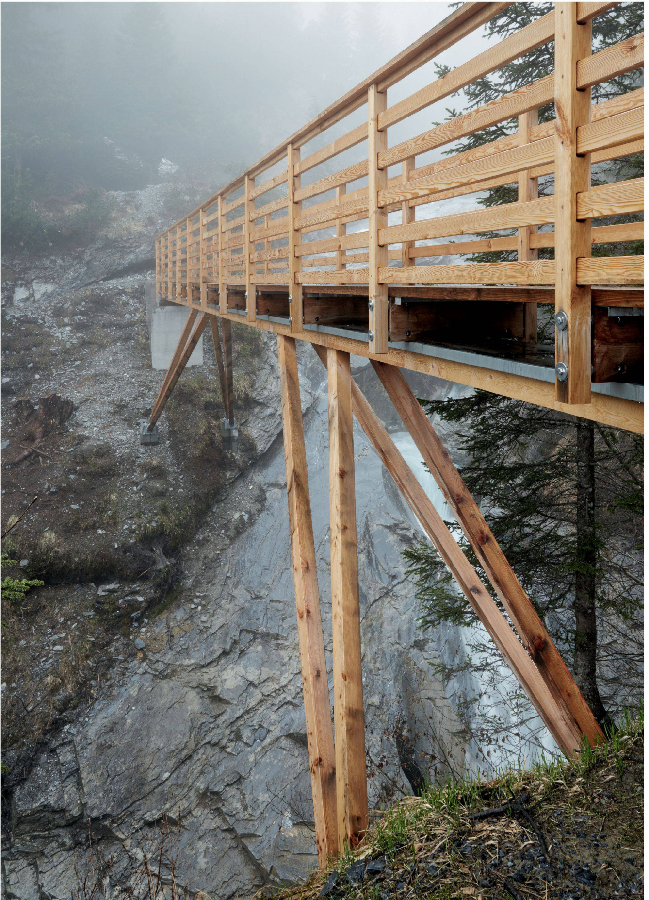
Ein filigranes Sprengwerk aus Lärchenholz dient nicht nur als Übergang, sondern auch als Ausguck in die Schlucht: die «Verweilbrücke».
