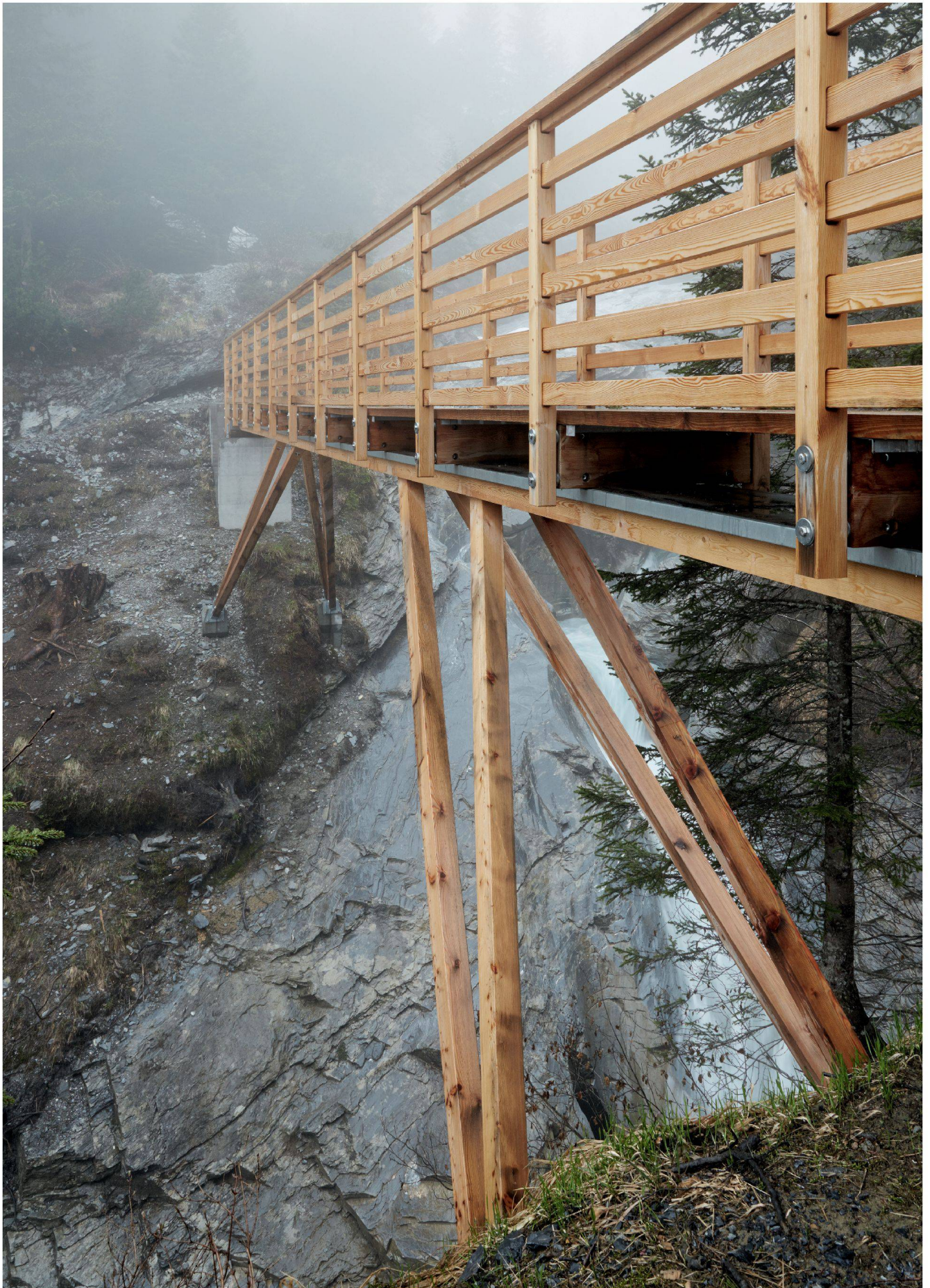
Ein filigranes Sprengwerk aus Lärchenholz dient nicht nur als Übergang, sondern auch als Ausguck in die Schlucht: die «Verweilbrücke».
