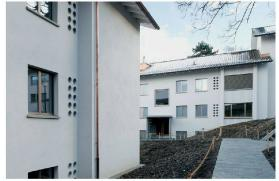
Da ein Dämmputz nachisoliert, blieben die Fassadendetails erhalten.
