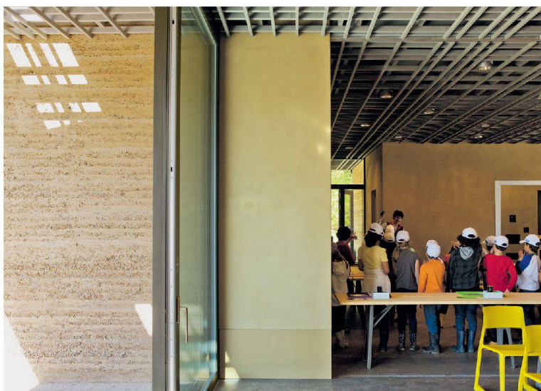
Lehm in verschiedenen Verarbeitungsformen: aussen gestampft, innen als Putz.
