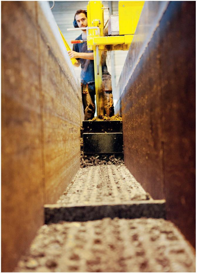
Vom Arbeiter gesteuert füllt eine Maschine die nächste Lehmschicht in die Schalung.
