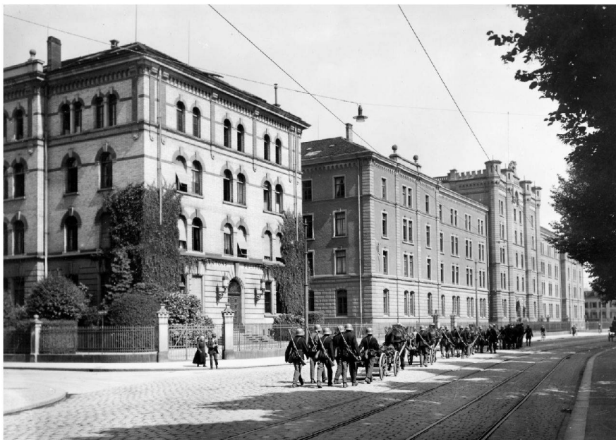
^ Kasernen für Polizei (1900) vorne und Militär (1875): stolze Fassaden an der Kasernenstrasse. Foto: Baugeschichtliches Archiv Zürich
