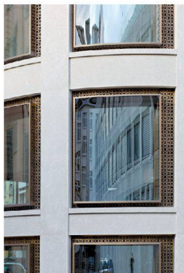
^Schmucker Rahmen für Ein- und Ausblicke – Kastenfenster mit seitlichem Lüftungsflügel.
