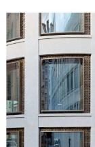
^Schmucker Rahmen für Einund Ausblicke – Kastenfenster mit seitlichem Lüftungsflügel.
