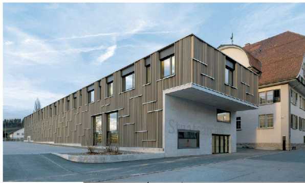
<Der neue Annex steht vor dem Zeughaus Herisau.
