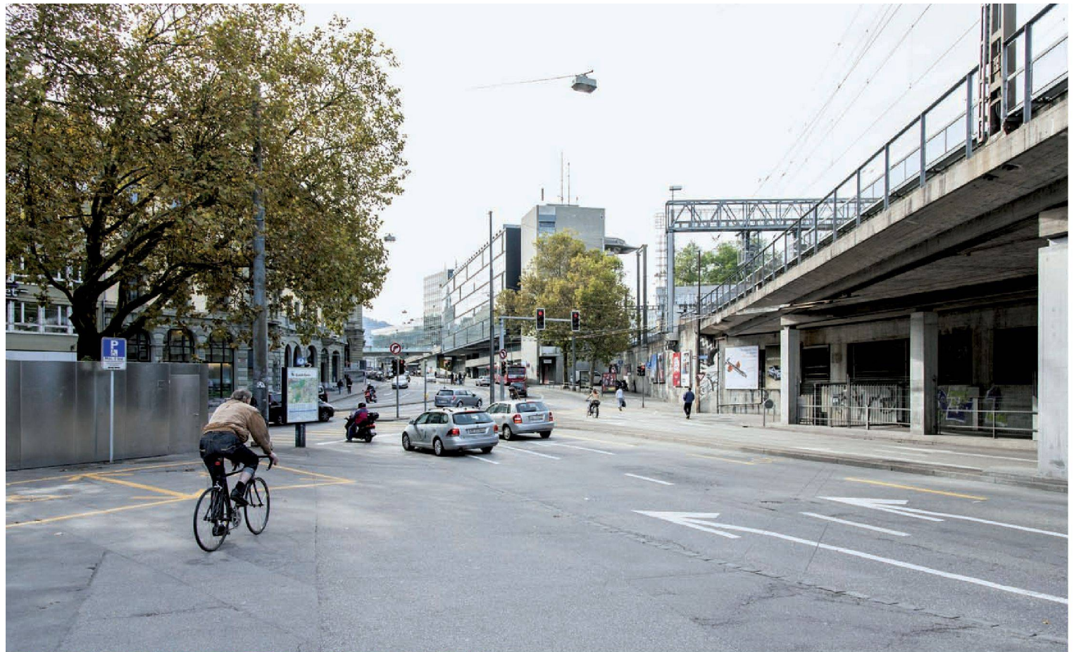
^Blick entlang der Strasse «Bollwerk» in Richtung Bahnhof. Wo einst eine Freitreppe zur Grossen Schanze hinaufführte, schliesst heute das SBB-Dienstgebäude den Raum.
