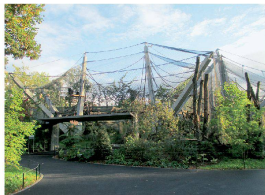
^ An Bambus mahnende Fiberglasstangen ermöglichen den Orang-Utans, sich schwingend von Baum zu Baum fortzubewegen.
