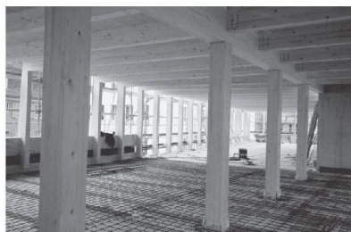
^... zusammen mit der vor Ort gegossenen Holz-Beton-Verbunddecke.
