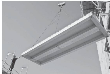
vEin Deckenelement wird angeliefert ...
