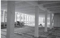
^... zusammen mit der vor Ort gegossenen Holz-Beton-Verbunddecke.
