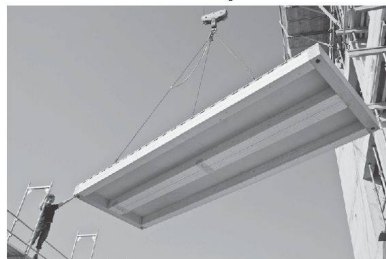
✓ Ein Deckenelement wird angeliefert ...
