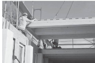
v... und in fünf Minuten verlegt.
