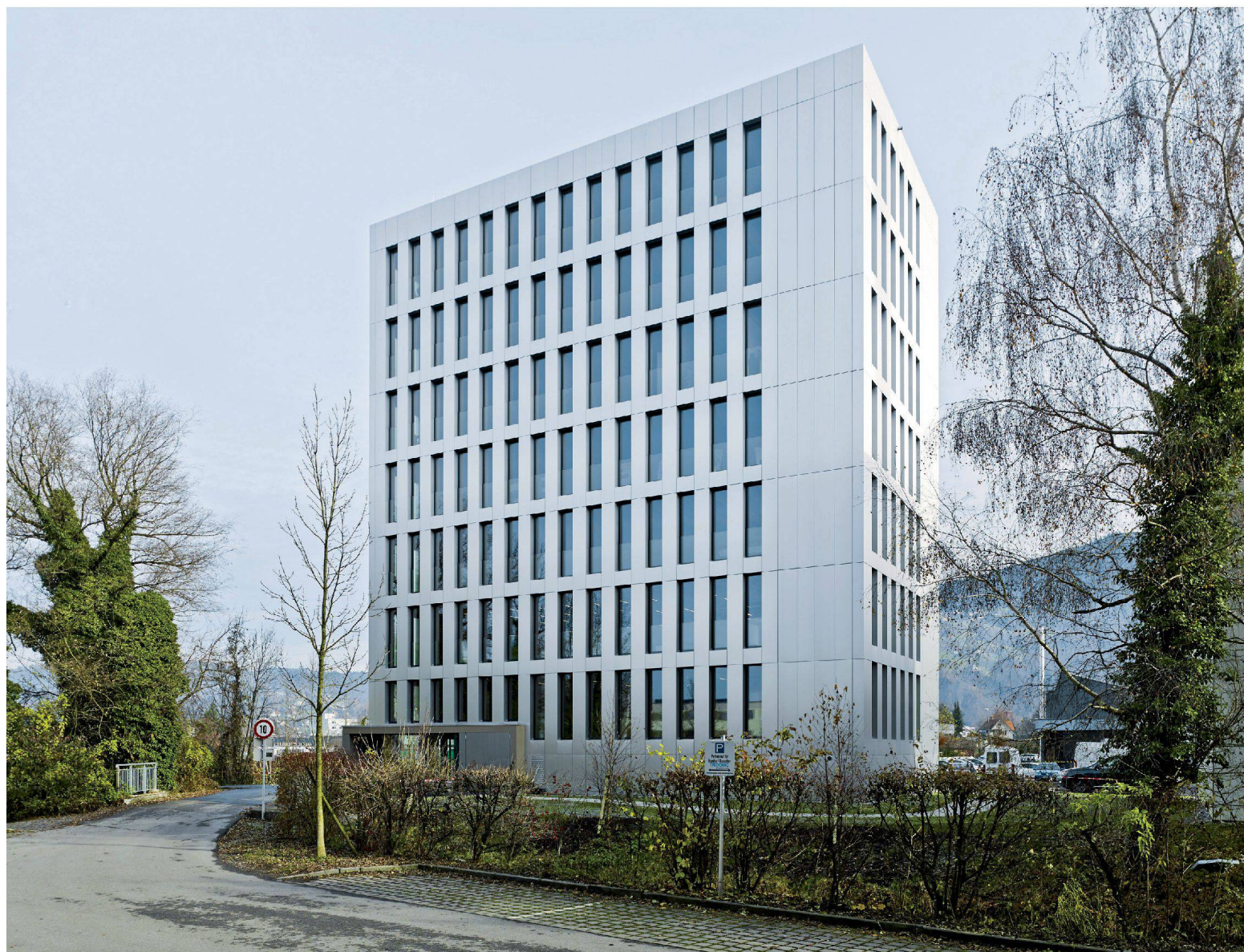
^Der Prototyp «LCT One» in Dornbirn. Die Fassade aus Aluminium-Sandwich-Platten ist nur eine Möglichkeit unter vielen.
