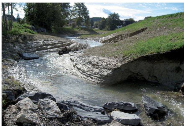
«Seinen definitiven Lauf formt sich der Bach selbst, der Bagger hat nur die grobe Linie vorgegeben.
