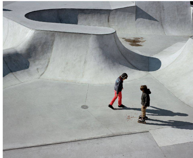
^ Wo früher eine improvisierte Holzkonstruktion stand, liegt heute eine Betonschale.
