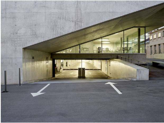
20__ Architektur: Gold für die neue Berufsschule in Freiburg. Foto: Kuster Frei
