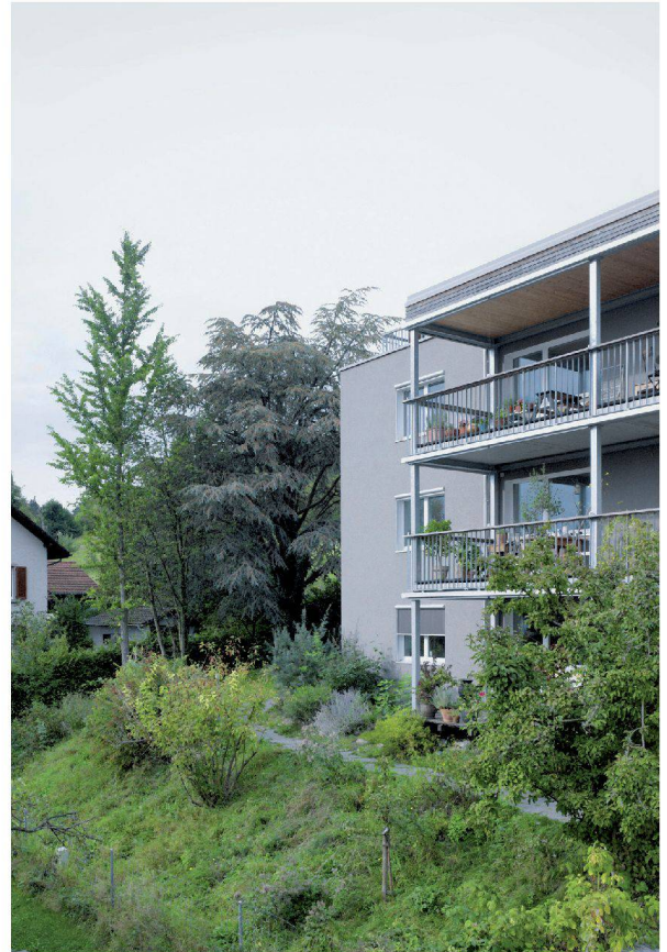
^Die grossen Balkone erweitern die Wohnräume.
