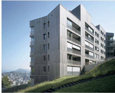
^Das Holz der Fassadenverkleidung wurde vorbewittert, sodass die Häuser eine homogene Oberfläche haben.
