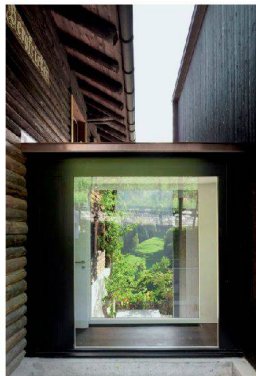
>48_ Alt und Neu sind punktuell verbunden.
