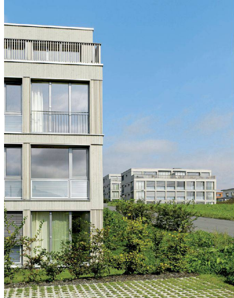
^36_Die Wohnüberbauung Silence in St. Erhard mit ihrer energieeffizienten Fassade.
