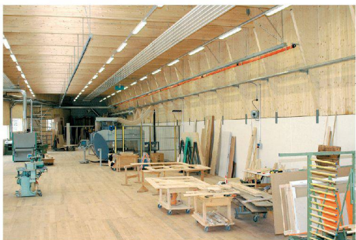
>30_Eine bestehende Mauer stützt die Halle.
