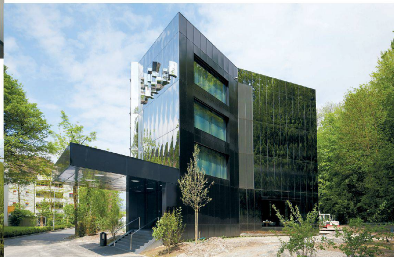
^35_Das Hotel City Garden in Zug lässt nicht erahnen, dass es eine reine Holzkonstruktion ist. Fotos: Roger Frei
