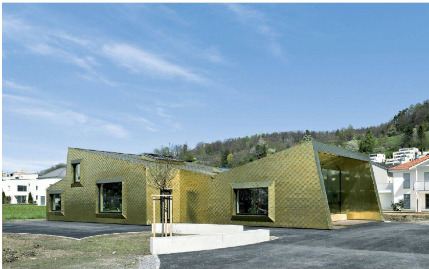
<21_Goldfisch oder Schmetterling? Der Kindergarten Zelgli West in Untersiggenthal. Fotos: Thomas Aus der Au
