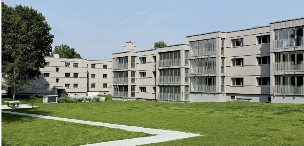
>20_Vorfabrizierte Holzelemente kleiden die Überbauung ein.
