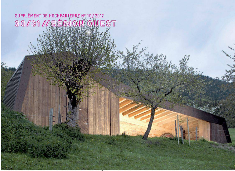
^6_ La créativité fait partie inhérente du hangar agricole à Lignièrès. Photos: Matthieu Gafsou
