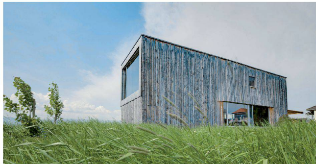
>11_ L'extérieur de la maison-boîte à côté de la zone agricole à Sugiez est d'allure discrète. Photos: Hansueli Schäfer
