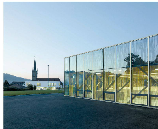
5 La construction de la salle de gymnastique d'Attalens s'inscrit dans l'agrandissement global de l'école du village.
