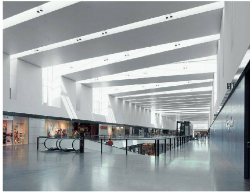
>7_ L'aération naturelle de l'espace central du nouveau Marin Centre est réalisée par des ouvrants pratiques dans la toiture et les vitrages. Photos: Thomas Jantscher
