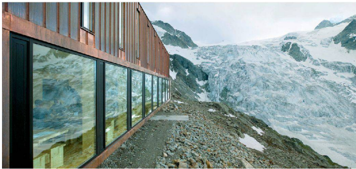
^8_ L'annexe de la cabane CAS de Moiry est, sous la façade en cuivre, un ouvrage en éléments préfabriqués en bois. Photos: Thomas Jantscher
