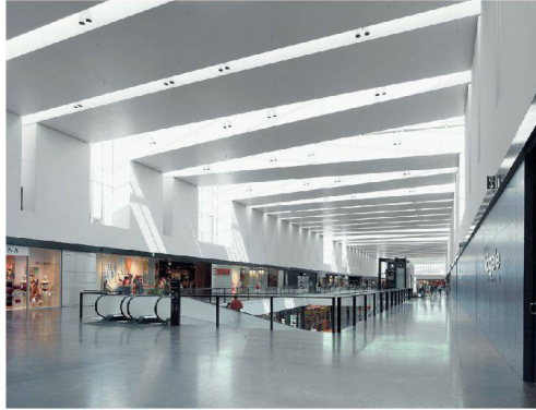
>7_ L'aération naturelle de l'espace central du nouveau Marin Centre est réalisée par des ouvrants pratiqués dans la toiture et les vitrages. Photos: Thomas Jantscher
