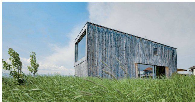
>11_ L'extérieur de la maison-boîte à côté de la zone agricole à Sugiez est d'allure discrète. Photos: Hansueli Schäfer
