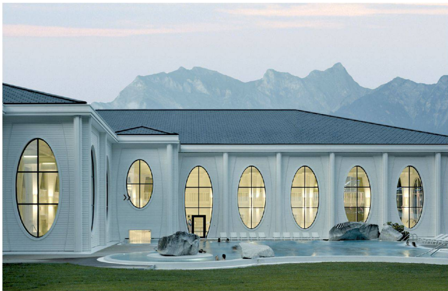
<3_Minergie-Fassadenelemente mit Tannenzholzverkleidungen in Verkehrsweiss, im Werk samt Gläsern zusammengebaut. Foto: Roland Bernath
