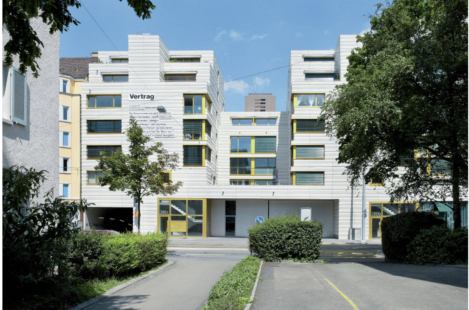
^2_ Die strassenseitigen Fassadenrücksprünge des Zürcher Wohn- und Geschäftshauses Badenerstrasse 378/380 brechen den Verkehrslärm; im Hintergrund die obersten Stockwerke eines der Hardau-Hochhäuser aus den Siebzigerjahren.
