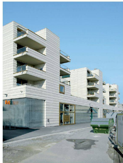
<2_ Fassade zum Park mit baumähnlicher Gliederung.
