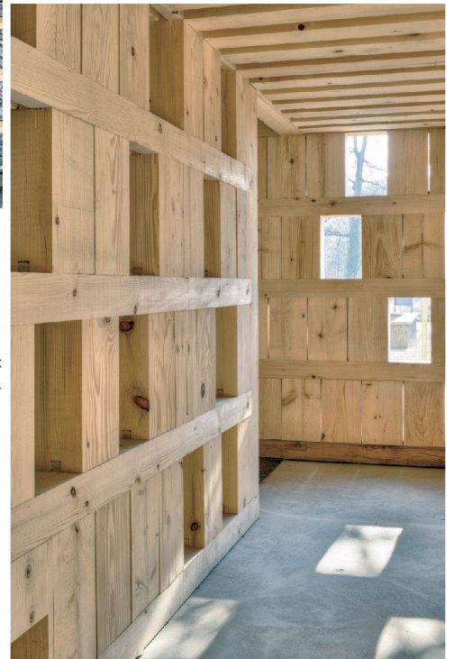
>1_Durchblicke und Ausblicke entstehen dank der Lücken zwischen den stehenden Füllhölzern.
