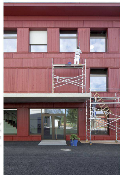
>Hand anlegen vor der grossen Einweihung: Die rote Farbe der Holzkassetten setzt einen kräftigen Akzent.
